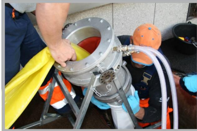
Der Anfang vom Ende der Probleme. Inlinersanierungen können bereits ab dem Durchmesser DN 100 durchgeführt werden.
